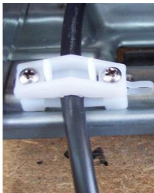
Figure 13 : Détail fixation double du câble
