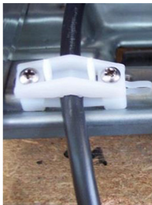
Рисунок 13: Деталь двойного крепления кабель
